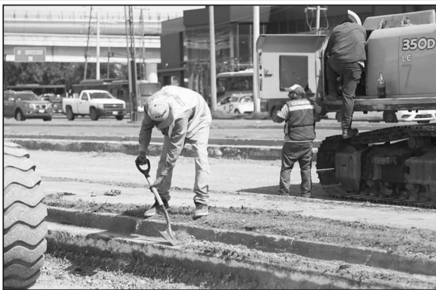
El alcalde Andrés Mijes Llovera estimó que los trabajos concluyan el 30 de noviembre.
